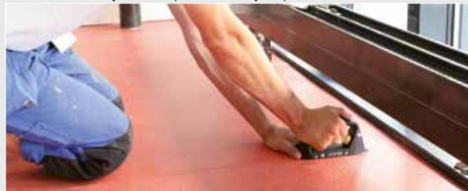
Guidage simple et précis grâce aux rouleaux de guidage intégrés
