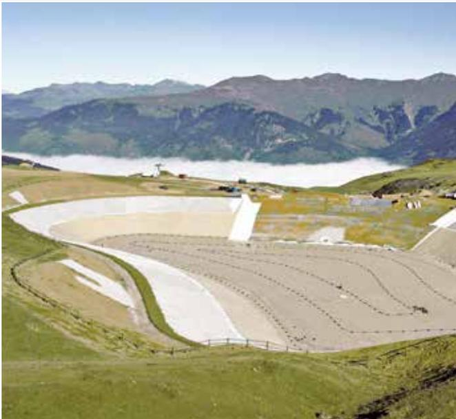
Réservoir d'eau HDPE 2.0 mm
