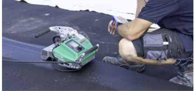
GEOSTAR LQS en utilisation sur le terrain.
