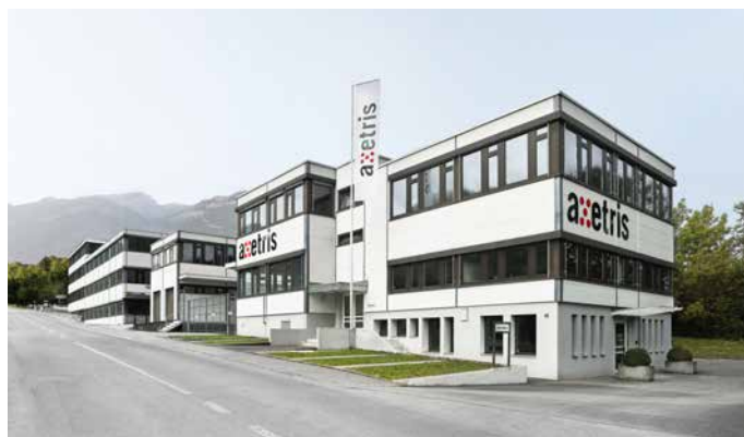
Leister Technologies AG, Production, Kaegiswil, Suisse
