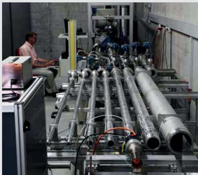
Leister installation de mesure
