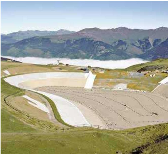
Réservoir d'eau HDPE 2.0 mm
